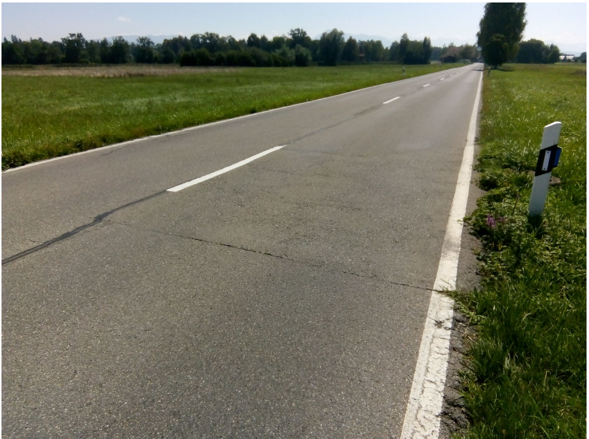
Aktuelle Aufnahme der Maschwanderstrasse in Hünenberg, die bald saniert wird.
